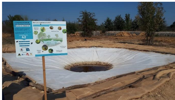
Création d'une mare avec étanchéité par bâche à Belleville-en-Beaujolais en septembre 2020
